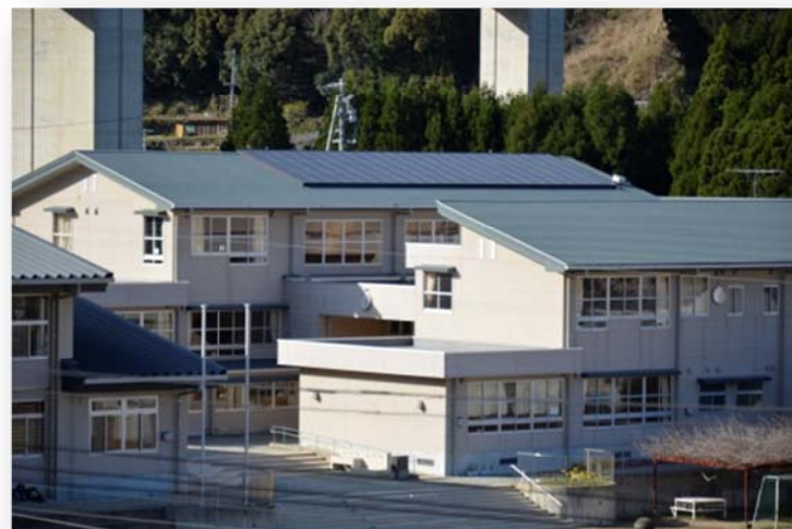
太陽電池モジュール 15kWh 1基
