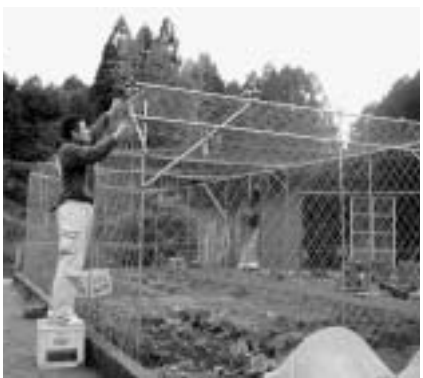
獣害対策用網の設置作業
