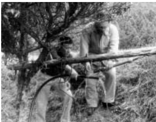
生活支援活動で、水道管の修理作業
